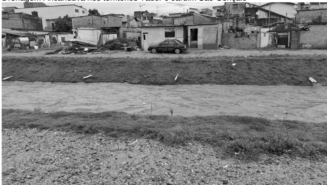
Figura 5 – Enchentes ocorridas em novembro e dezembro de 2023 após obras do PAC Drenagem Aricanduva nos territórios Tabor e Jardim São Gonçalo
